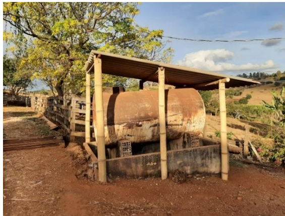
Figura 09: Ponto de abastecimento que deve ser realizado melhorias.
